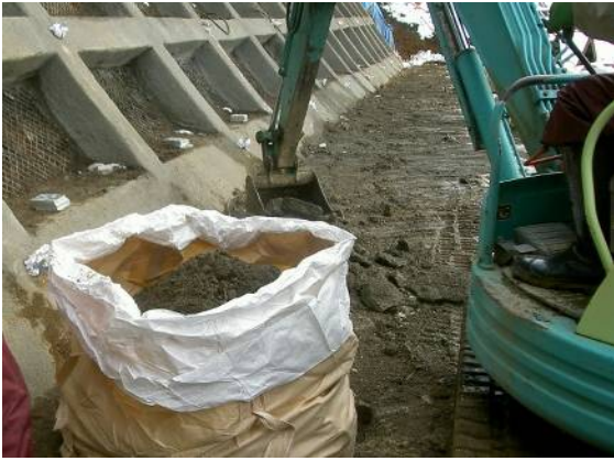
現場の土とモルタル殻が混じってしまわないように丁寧に集積します。重さは、この袋1つで1tにもなります。
