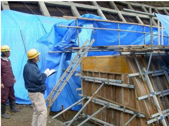
安全衛生パトロール風景。このとき、残材がきちんと片付いているか、産廃の分別状況、車輛や重機の整備状況などもチェックします。道路を汚していないか、埃がたっていないかなどもポイントです。
